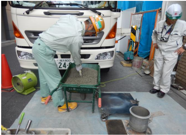
打設前のコンクリートを一部運び入れて各試験を行います。 この試験を「受け入れ検査」と称します。
