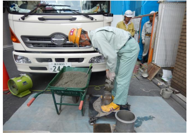
まずは、コンクリートの柔らかさを診るため口が開いた円錐型の容器にコンクリートを詰めています。この容器は、スランプコーンと称します。
